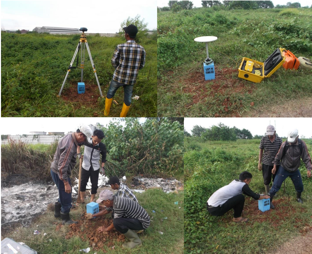
LARAP Proyek Pembangunan Gardu Induk 150 kV SEPATAN Ext.
